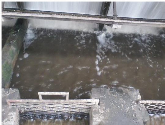
Gambar 2.44 Kolam Penampungan Air Dingin
