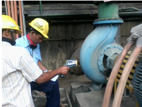
Gambar 3.4 Proses Pengecekan Temperatur Pompa
